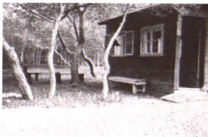
Die aus einem Möbellift gebaute Waldkapelle in unserem Karmelpark.
