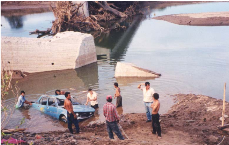
Eingestürzte Brücke nach dem verheerenden Hurrikan »Mitch« 1998
