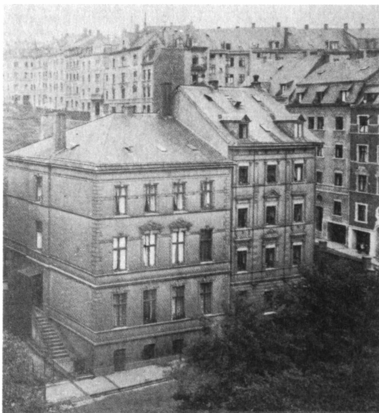
Das 1900 erbaute Alters- und Frauenhaus
