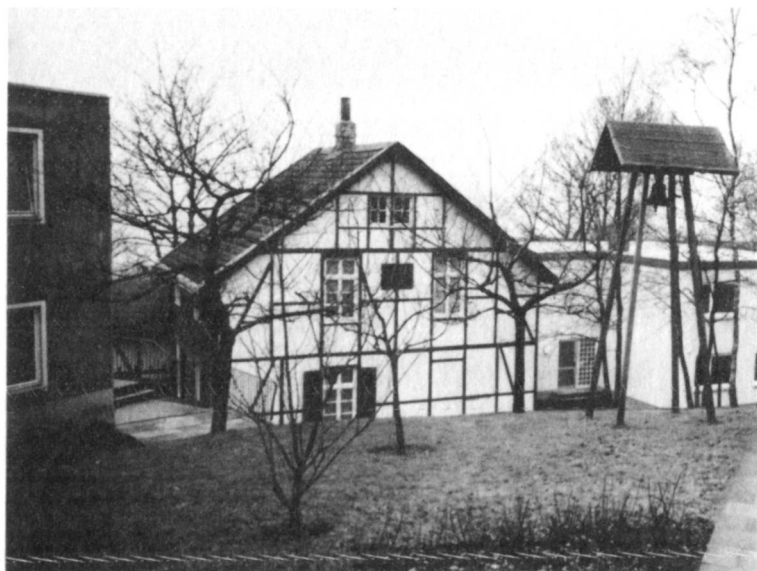
Das alte Fachwerkhaus umrahmt von den neuen Seminargebäuden der Evangelischen Gesellschaft
