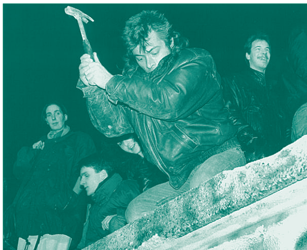
Ein »Mauerspecht« bei der Arbeit
